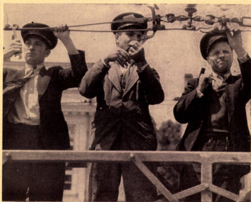
Repararea cablului electric
