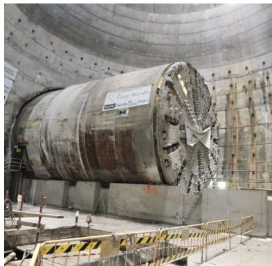
Tuneladora a Mandri
