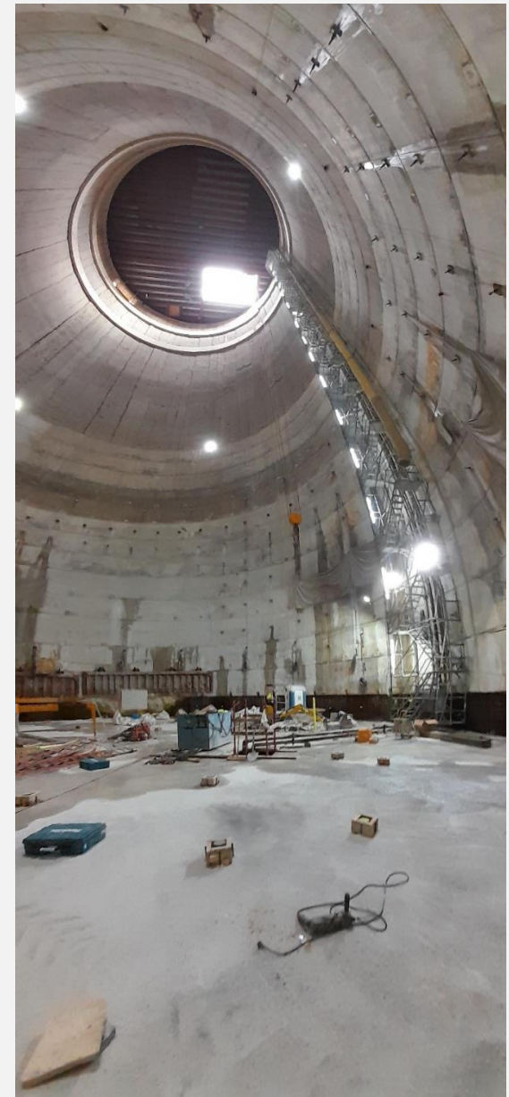
Execució llosa de fons del pou de l'estació
